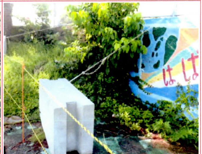
写真4 テニスコート南側塀に設置されたコンクリート塊
