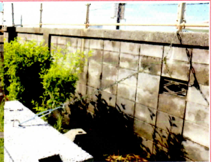
写真2 コンクリート塊がワイヤーで接続
