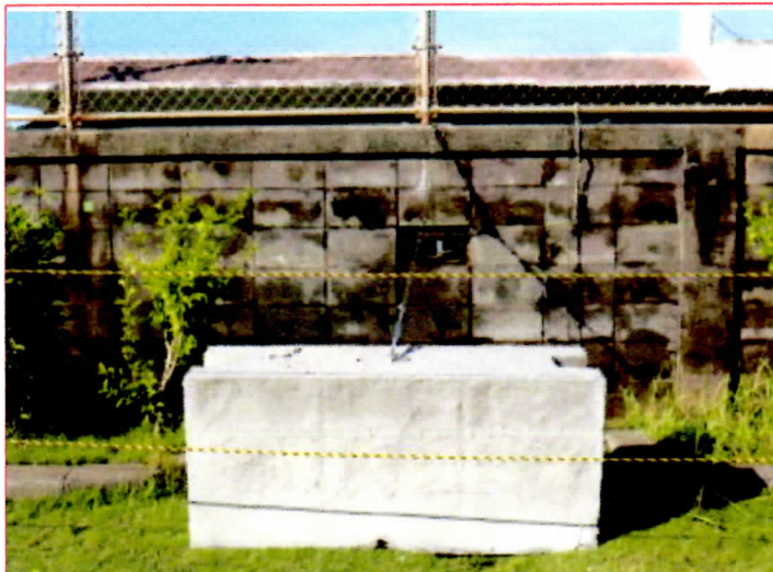
写真1 運動場南側塀に設置されたコンクリート塊
